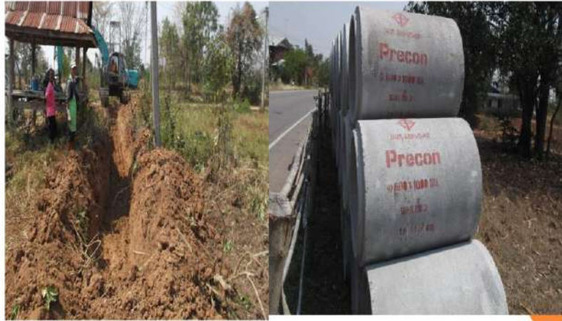
โครงการวางท่อระบายน้ำ หมู่ที่ 14 ขณะดำเนินการ
