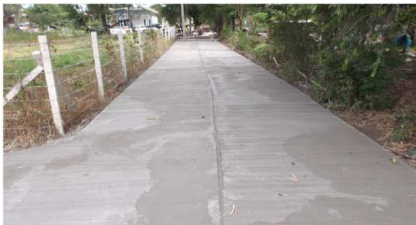
โครงการก่อสร้างถนน ค.ส.อ. หมู่ที่ 3 หลังดำเนินการ
