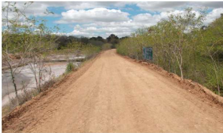
โครงการปรับปรุงถนนหินคลุก หมู่ที่ 1 หลังดำเนินการ
